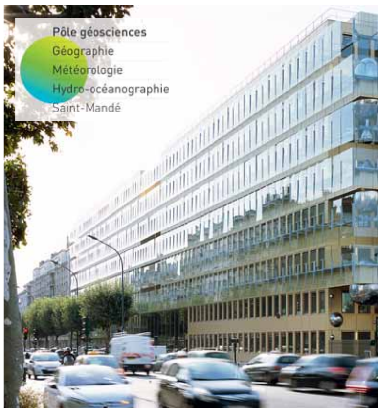
Bâtiment Pôle Géosciences géographie, hydro-océanographie, météorologie abritant l'antenne du SHOM de Saint-Mandé
