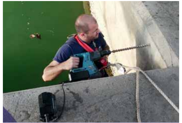
Scellement d'un repère fondamental dans le port pour la création d'un observatoire permanent
