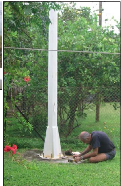
Installation d'un repère géodésique
