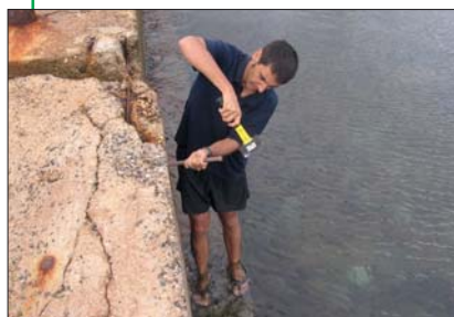
Installation d'un repère de tirant d'air
