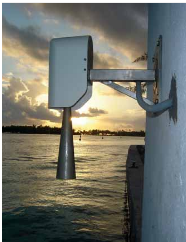
Abri avec les équipements de la station et radar installé
