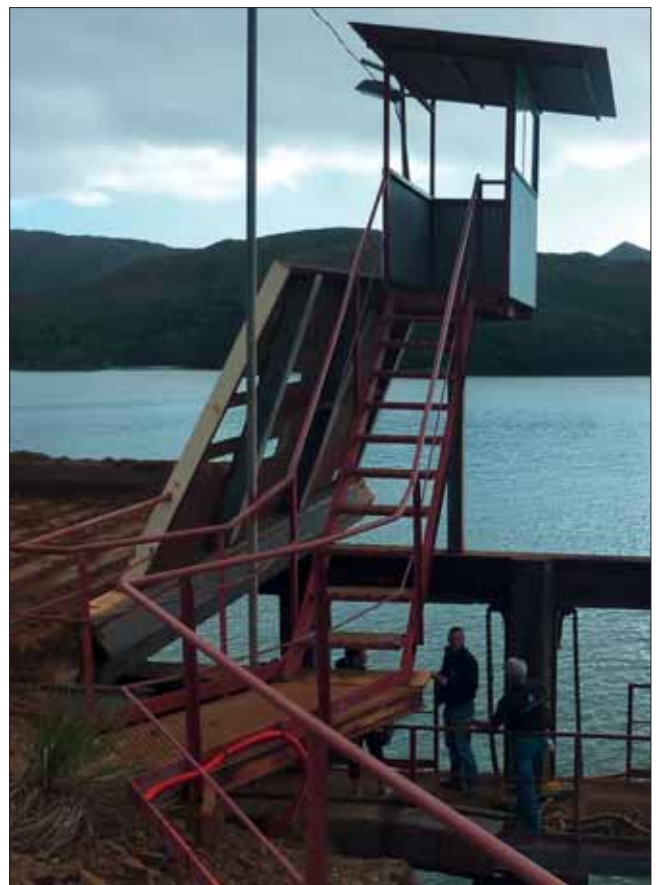
Guérite pour installer l'antenne Yagi et les panneaux solaires
