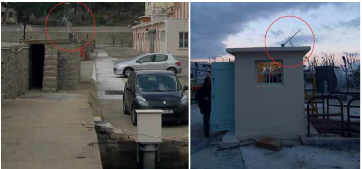
Sites instrumentés d'une transmission satellite : Antenne satellite dans la darse d'Aspretto à Ajaccio (à gauche) à Toulon (à droite)
