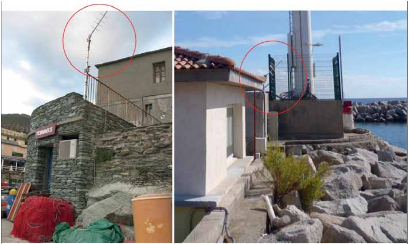
Sites instrumentés d'une transmission satellite : Antenne satellite sur la poissonnerie de Centuri (à gauche) Antenne satellite dans le port de Solenzara (à droite)
