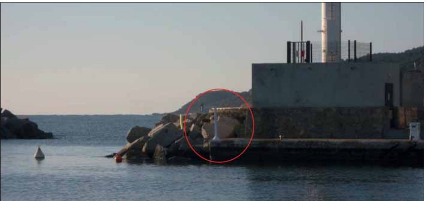
Télémetre radar sur sa potence dans le port de Solenzara
