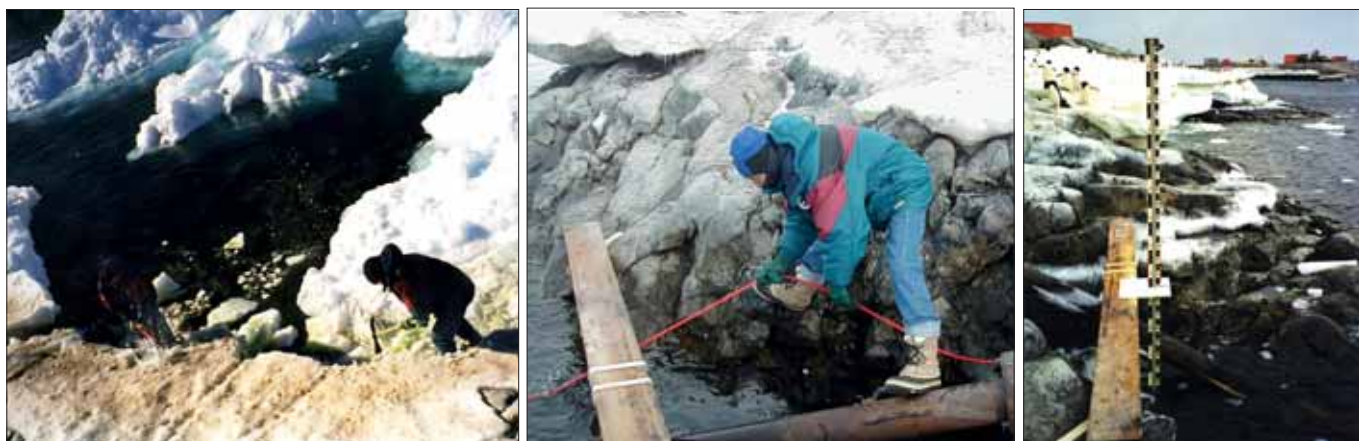
Travaux sur le marégraphe permanent de la base Dumont D'Urville
