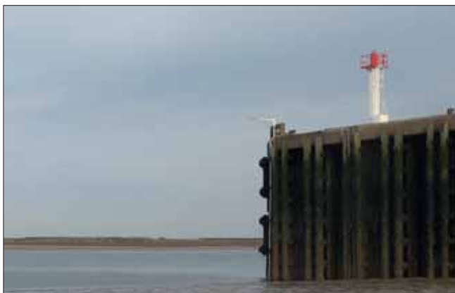
Fig.4 : Vue de situation du marégraphe de Boulogne-sur-Mer où la distance à mesurer peut dépasser 12 m
