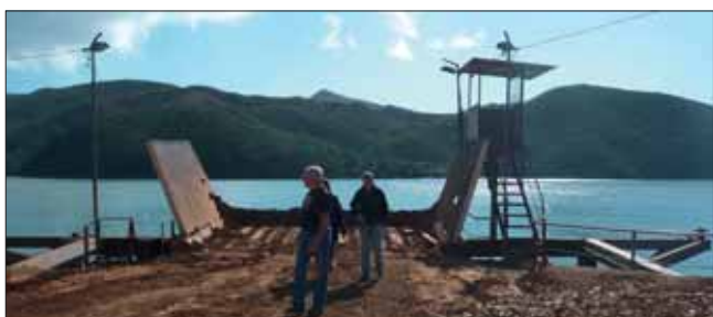
Wharf de transbordement
